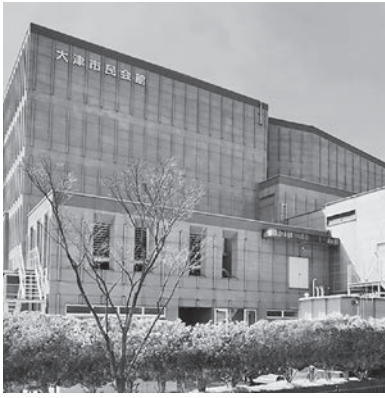
なぎさ公園周辺に位置する市民会館
