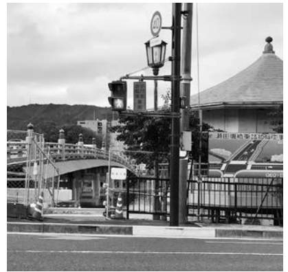
早期の整備が望まれる瀬田唐橋の拡幅工事
