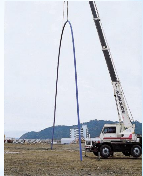
水道配水用ポリエチレン管 （電気融着継手）
