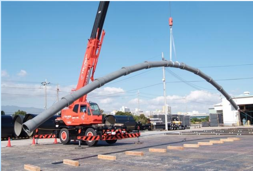
ダクタイル鋳鉄管（耐震継手）
