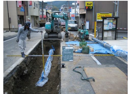
② 水道管の布設状況
