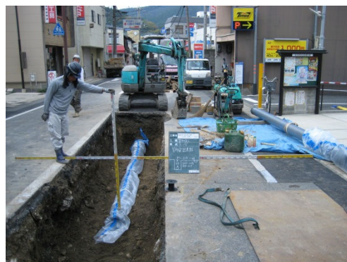
② 水道管の布設状況
