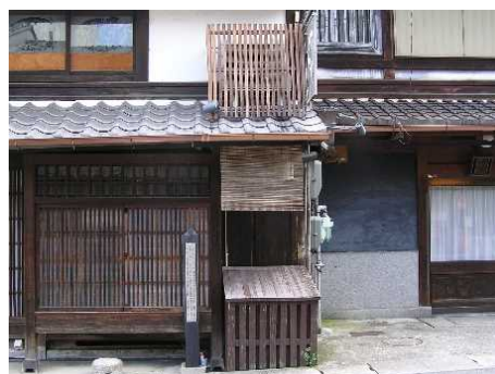
ルーバーなどにより室外機などの設備を隠した 例
