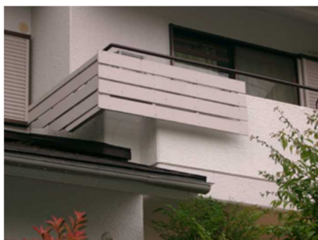
バルコニーに目隠し板を設置することにより 室外機などの設備を隠した例
