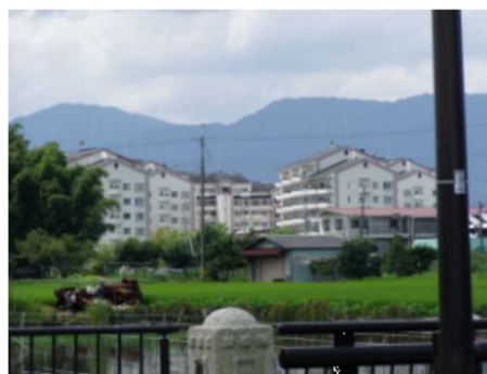
複数の住棟を、屋根の勾配の向きと壁面の位置に変化を持たせながら配置することで、変化のある街区景観を形成した例 また、勾配屋根が背後の山並みと調和したスカイラインを形成しています
