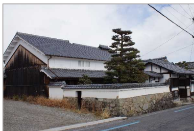
穴太衆積みの石積み擁壁に築地塀を載せている例
