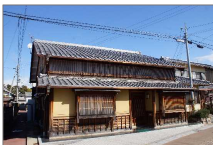
歴史的まちなみ景観との調和に配慮し、切妻平入り、和瓦葺き、出格子など伝統的木造建築の様式を残している例
