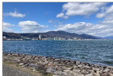
生息環境に配慮し多孔質な石張りの構造とした例
