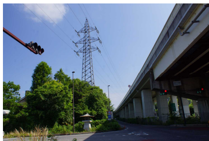
基部の緑化により鉄塔の持つ圧迫感を軽減させ、周辺景観との調和を図った例
