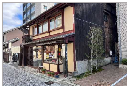
土壁や板張りの様式を良好に残している例
