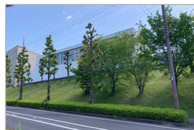
造成に際し、のり面を適切に緑化することで新しいまちなみ景観に潤いを与えている例
