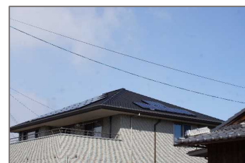
黒色のパネルして屋根材になじませている例
