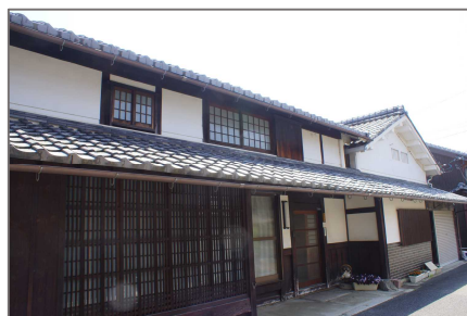
白漆喰や腰板張りの様式を良好に残している例
