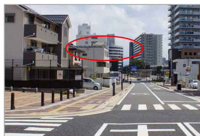
陸屋根の上にパネルを配置している例
