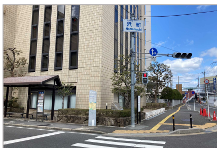
外構の石積み擁壁の植栽帯の例
