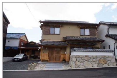
穴太衆積みの石積み擁壁を新設して築地塀を載せている例
