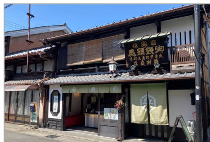
伝統様式の木製看板や室外機を木格子でめかくしている例
