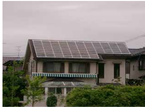
太陽光パネルを屋根材として一体的にデザインした例
