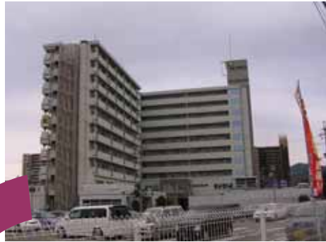
屋外階段をルーバーにより覆った例
