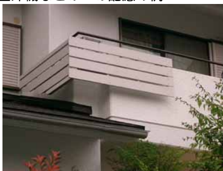
バルコニーに目隠し板を設置することにより室外機などの設備を隠した例
