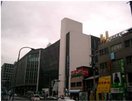
建築物の外壁と形態・意匠を合わせることで、建築物と一体的にデザインされた塔屋の例
