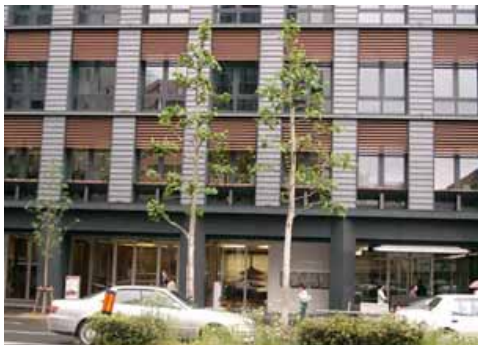
開口部の意匠を工夫し、壁面を凹凸のあるデザインとすることにより圧迫感を緩和した例
