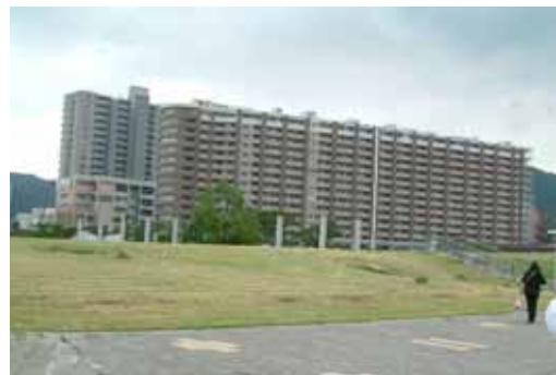
上層階の外壁の色彩を変化させることで、圧迫感を緩和した例
