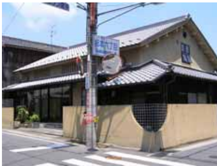
歴史的まちなみ景観との調和に配慮し、切妻平入り、和瓦葺き、虫籠窓など伝統的木造建築の様式を取り入れた例
