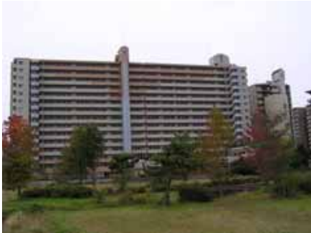
ベランダを外壁と一体的にデザインした例
