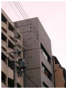
屋上の壁面（パラペット）を高く立ち上げることで、屋上の設備を目隠しした例
