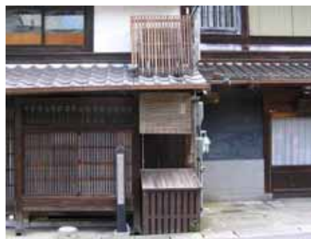
ルーバーなどにより室外機などの設備を隠した例
