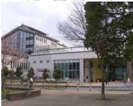
屋上の設備をパンチングメタルのフェンスにより目隠しした例
