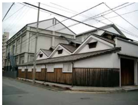
地域特性である酒蔵のまちの屋並みの連続性に配慮し、勾配屋根とした工場の例
