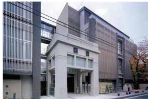
壁面を分節化することで周囲への圧迫感を緩和した例 さらに格子状のルーバーを設けることで、壁面に変化を与えるとともに、歴史的まちなみとの調和を図っている
