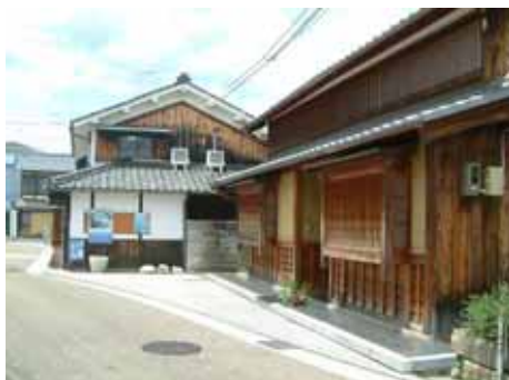
周辺の伝統的な建築物と同様の素材・様式を用いることで、歴史的まちなみを保全した例
