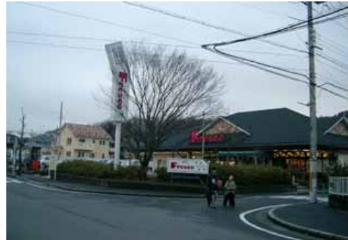
住宅地内の商業施設において、駐車場の周囲に植栽を行い、車を遮蔽することで落ち着いた住宅地景観と調和させている例
