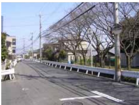
河川に面した空地に花木の植栽を行うことで、緑豊かな景観を創出した例
