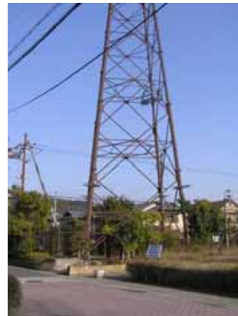
基部の緑化により鉄塔の持つ圧迫感を軽減させ、周辺景観との調和を図った例
