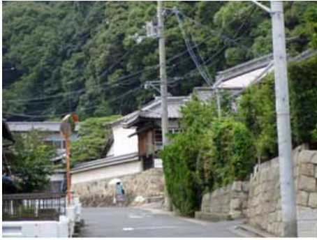
擁壁を石積みとすることで歴史的なまちなみ景観を維持している例
