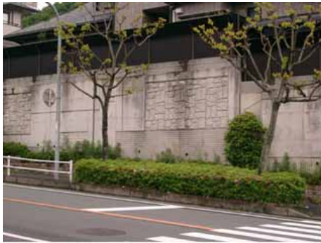
コンクリートの擁壁を化粧型枠により修景処理することのでまちなみ景観に変化を与えている例
