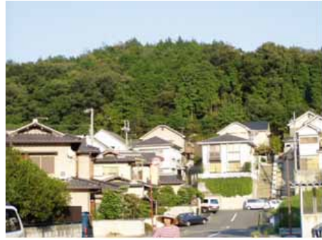
コンクリート擁壁の壁面に植栽を行うことで背後の山並みと調和した潤いのある景観を形成している例
