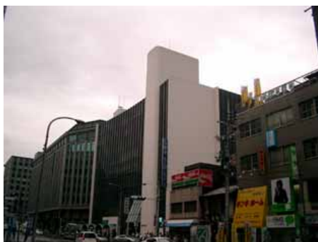
建築物の外壁と形態・意匠を合わせることで、建築物と一体的にデザインされた塔屋の例
