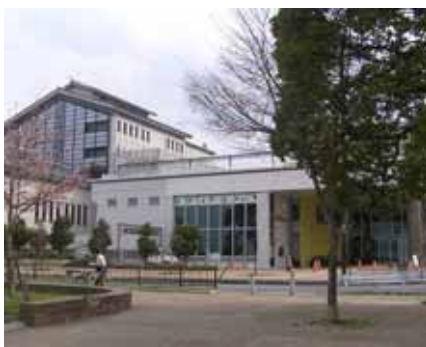
屋上の設備をパンチングメタルのフェンスにより目隠しした例
