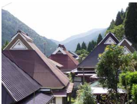
地域固有の伝統的な入母屋造の屋根デザインを踏襲することで、特徴ある集落景観を維持している例
