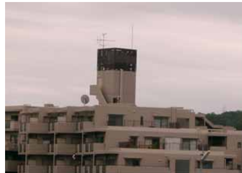
ルーバーにより、屋上の設備を目隠しした例
