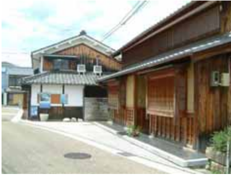
周辺の伝統的な建築物と同様の素材・様式を用いることで、歴史的まちなみを保全した例
