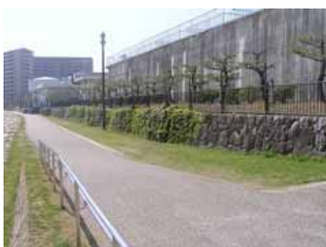
擁壁の高さを抑えとともに、植栽により周辺の景観と調和させた例
