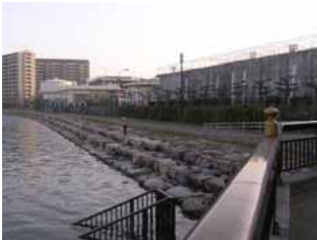
生物の生息環境に配慮し、多孔質な石積みの構造とした例（再掲）
