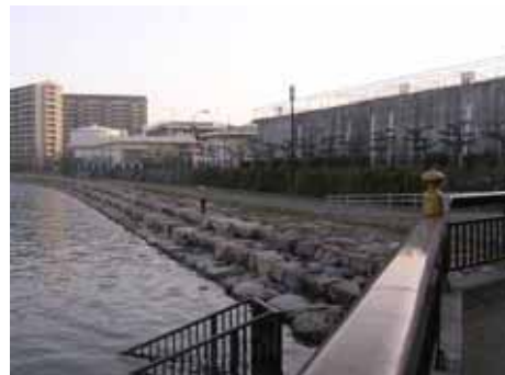
生物の生息環境に配慮し、多孔質な石積みの構造とした例
