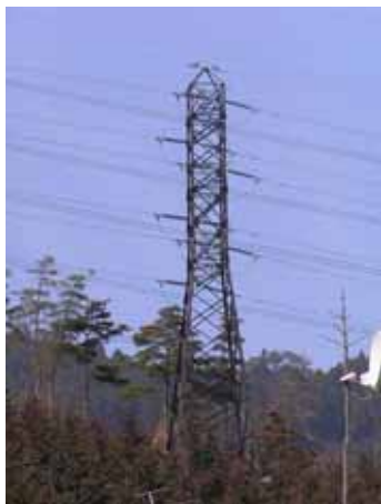
背景の山並みの景観に配慮し、焦げ茶色とすることで、周辺の景観と調和させた例
