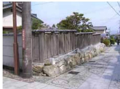
自然石と木材を使用した塀の例
