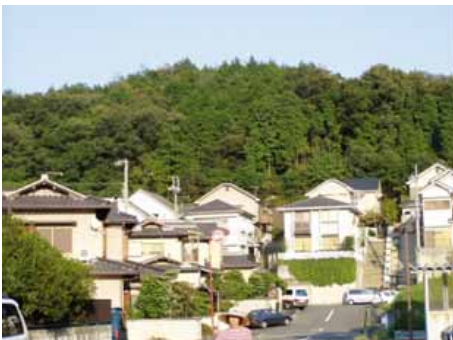
コンクリート擁壁の壁面に植栽を行うことで背後の山並みと調和した潤いのある景観を形成している例
