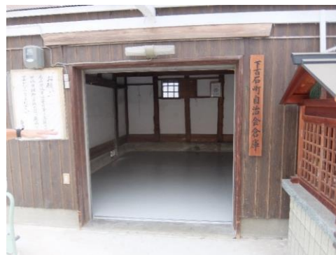
大津祭曳山殺生石山保存修理
