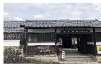
【旧岡本家住宅】 ・令和3年度指定 ・令和4年度修理
