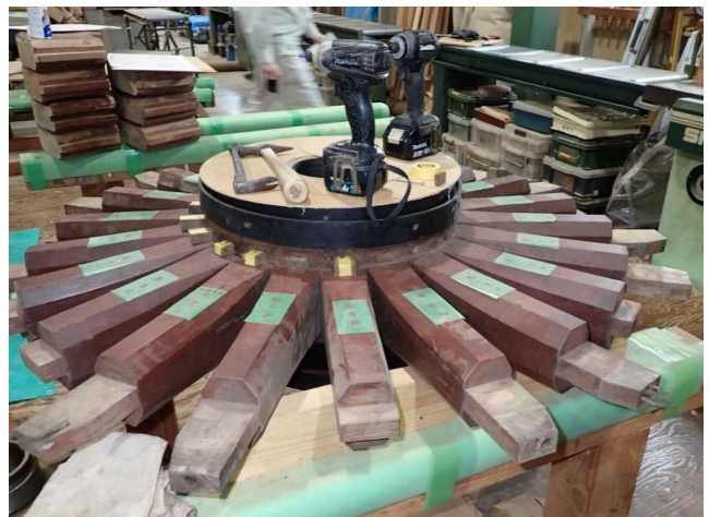
大津祭曳山西行桜狸山 車輪修理
