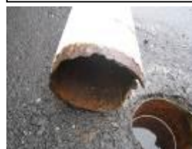
ポール看板の倒壊
