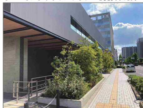
低層部をピロティにするとともに壁面後退部分を緑化し、建築物の圧迫感を緩和するとともにまちなみにうらおいを提供した例
