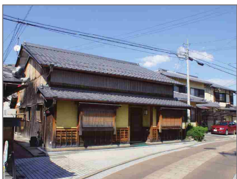
地域で伝統的に使われてきた建材の色彩等、慣れ親しんだ慣例色を用いた例
