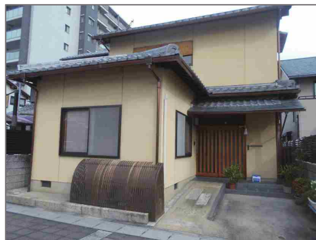
犬矢来により室外機を隠した例
