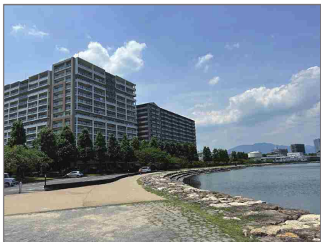
自然の緑を引き立てる低彩度色の外装の例
