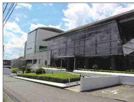
建築物（業務ビル）の前面に空地を設け、植栽帯を整備することで、建築物の圧迫感を緩和するとともにまちなみにうらおいを提供した例
