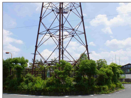
基部の緑化により鉄塔のもつ圧迫感を軽減させ、周辺景観との調和を図った例
