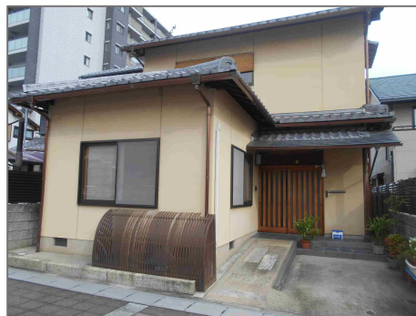
犬矢来により室外機を隠した例
