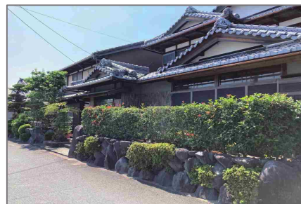
通りに面して生垣を配置している例
