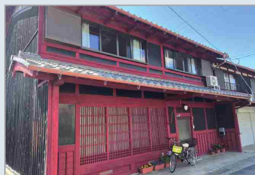
格子戸や腰板、柱等の木製部分に弁柄色の保護塗装を用いている例
