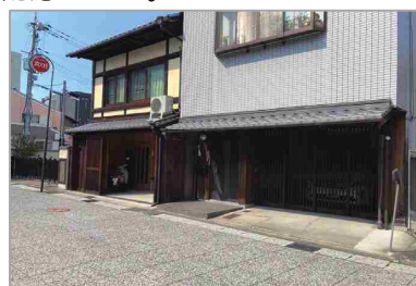
庇を設けまちなみの連続性に配慮した例
