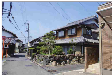
野面石の石積みを外構に用いている例
