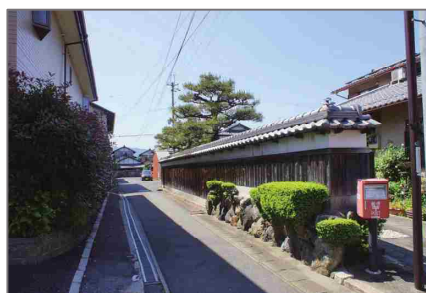
道路から後退した場所に塀を設けてまちなみのつながりに配慮している例
