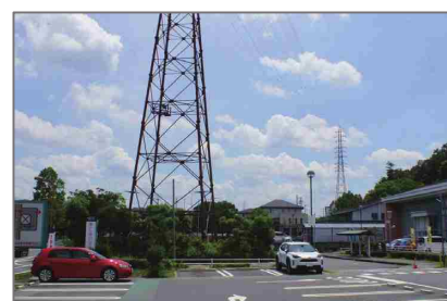
周辺景観や足元の緑地景観に配慮し、焦げ茶色の外観色彩としている例
