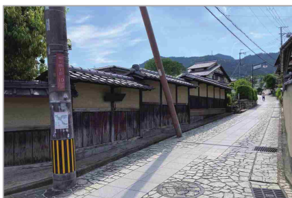
坂道に沿って雁行した美しい塀の形態
