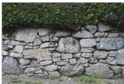
穴太衆積みの擁壁
