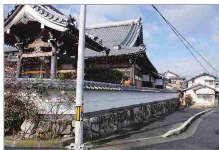
野面石の石積み擁壁に築地塀を載せている例
