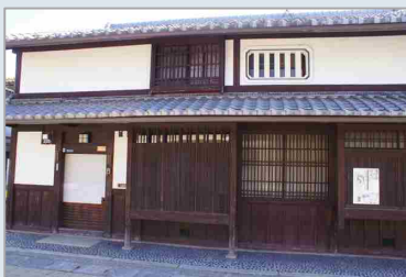
出格子や腰板、柱等の木製部分に濃茶色の保護塗装を用いている例
