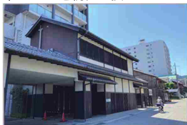
マンションの低層部を和風基調の設えとした例
