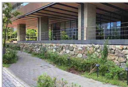
自然石を用いた石積み擁壁の例
