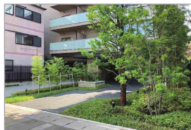
道路から後退し修景緑化を行っている例
