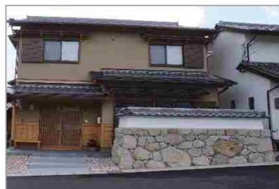
穴太衆積みの擁壁を新設して築地塀を載せている例
