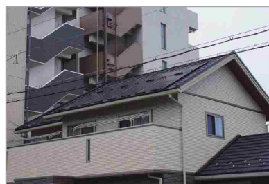
屋根材と同色にして目立たなくしている例
