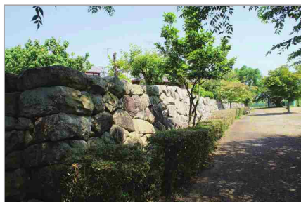
野面石を用いて多孔質な構造としている例
