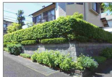
通りに面して生垣を配置している例
