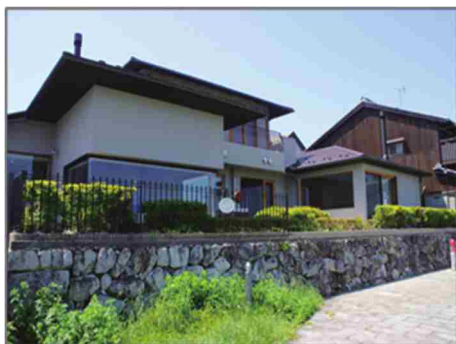
湖岸緑地に面した敷地を緑化し、湖岸の親水空間（公共空間）と一体となった水辺景観を形成している例
