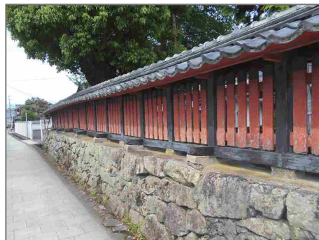
自然石と木材を使用した塀の例
