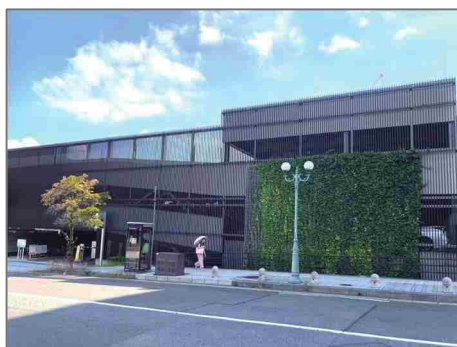
立体駐車場をルーバーと壁面緑化で覆った例
