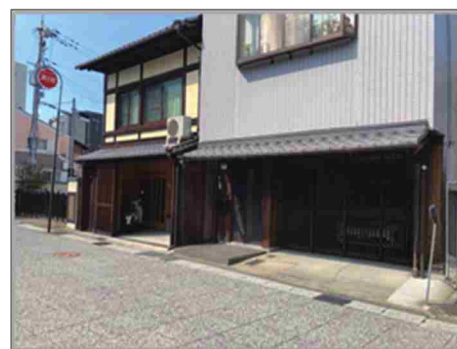
1階部分に庇を設けまちなみの連続性に配慮した例
