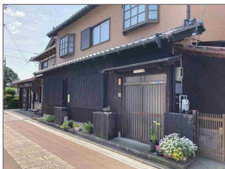
周辺の伝統的な建築物と同様の素材・様式を用いることで、歴史的なまちなみを保全した例
