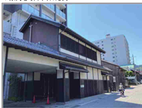
マンションの低層部を和風基調の設えとした例
