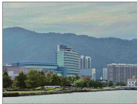
背後の山並みに溶け込む、微妙な色彩の外装の例
