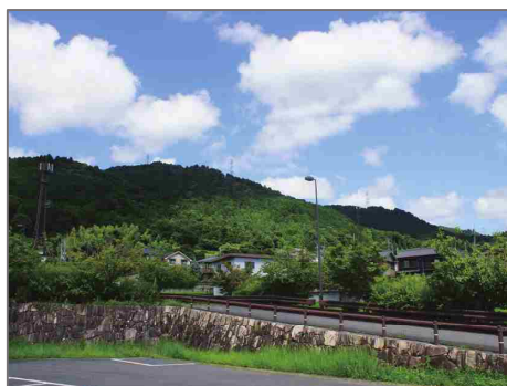
自然石の石積み擁壁とすることで、自然景観と調和させた例
