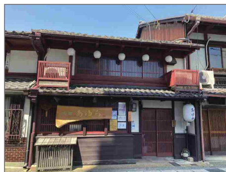
ルーバー等により室外機等の設備を隠した例
