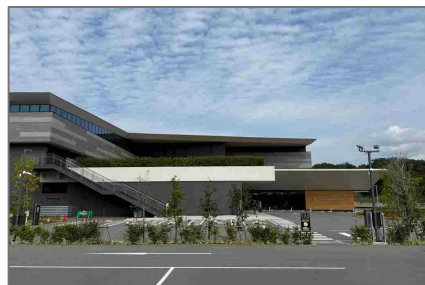
壁面に奥行きと変化をもたせ屋上緑化を施すなど自然景観に調和するよう工夫した建築物
