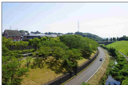
山と湖岸を結ぶ緑の軸線として機能する護岸
