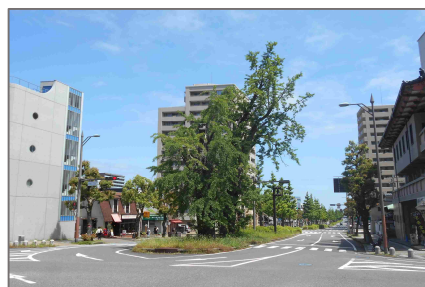
既存樹木を保存した道路整備
