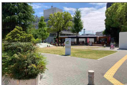
前面歩道部に対して開放的なエントランス
