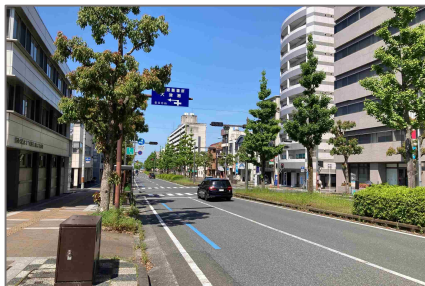
電線が地中化されたシンボルロード
