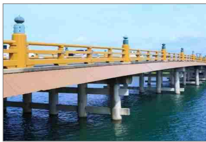
かつてあった橋の趣を感じさせる造りの橋
