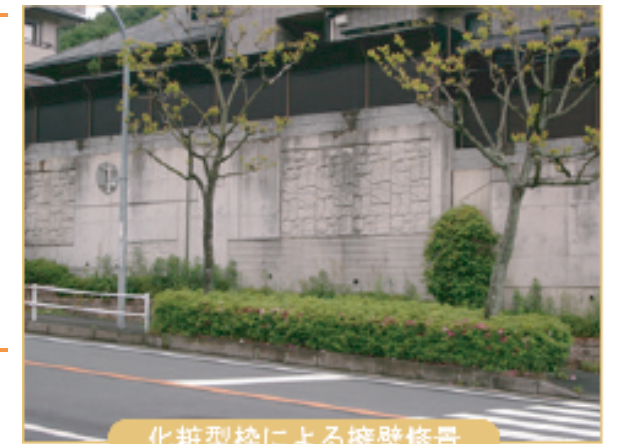
化粧型枠による擁壁修景
