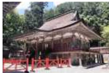
写2-10-1 日吉大社西本宮本殿 （提供：日吉大社）
