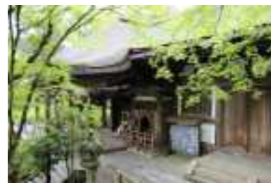
写2-9-2 石山寺本堂 (提供：石山寺)
