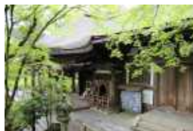
写1-4-44 石山寺本堂 (提供：石山寺)
