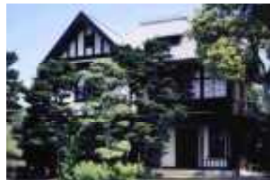
写1-4-8 旧伊庭家住宅（住友活機園）洋館 （提供：住友林業株式会社）
