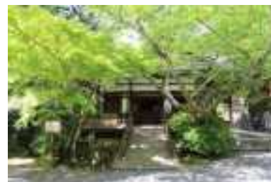
写2-9-20 石山寺蓮如堂（提供：石山寺）
