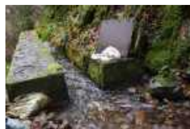
写2-2-14 野離子川の取水口
