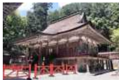
写1-4-43 日吉大社西本宮本殿 (提供：日吉大社)
