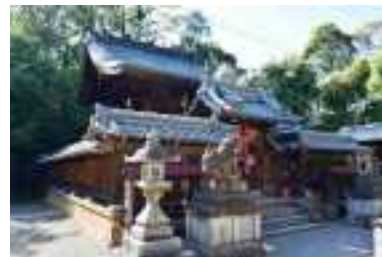
写2-9-25 近津尾神社本殿
