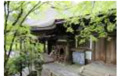
写1-4-4 石山寺本堂 （提供：石山寺）
