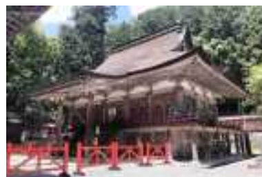
写1-4-1 日吉大社西本宮本殿 (提供:日吉大社)
