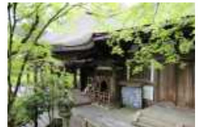
写 1-3-13 石山寺本堂 （提供：石山寺）
