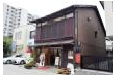
写2-11-7 上京町町家主屋
