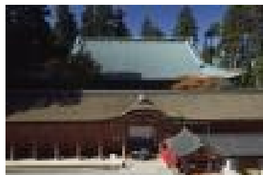
写1-4-2 延暦寺根本中堂及び 根本中堂廻廊(提供：延暦寺)
