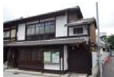
写2-11-8 中京町町家主屋
