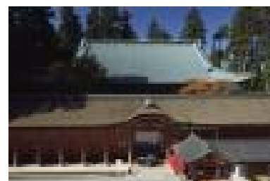
写 1-4-41 延暦寺根本中堂及び根本中堂廻廊（提供：延暦寺）
