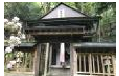
写2-4-9 関蟬丸神社上社本殿 ※現在は覆屋が設けられている
