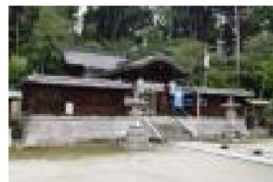
写2-6-16 志賀八幡神社本殿
