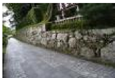
写1-4-17 穴太衆積みの石垣
