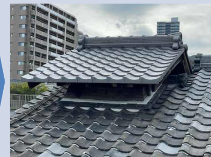
北川家住宅(屋根修理後)
