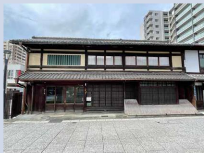
北川家住宅(外観修理前)
