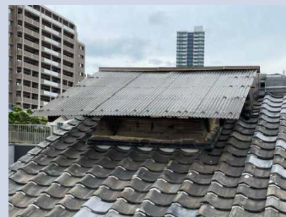
北川家住宅(屋根修理前)
