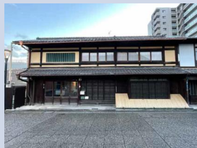
北川家住宅(外観修理後)
