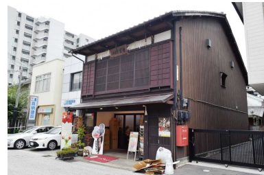
写2-11-7 上京町町家主屋
