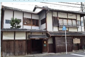
まめしん 豆信料亭棟
