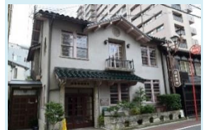
石田家住宅洋館
