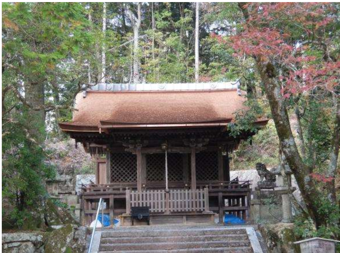
屋根葺き替えが完了した神田神社本殿(令和2・3年度事業)
