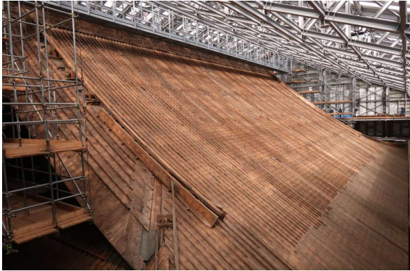
国宝延暦寺根本中堂の修理
