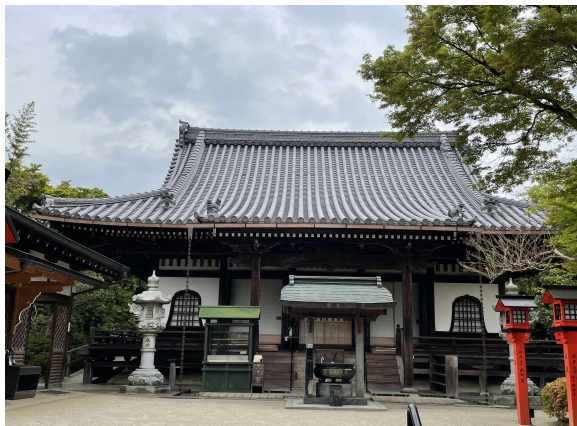
修理後の律院本堂
