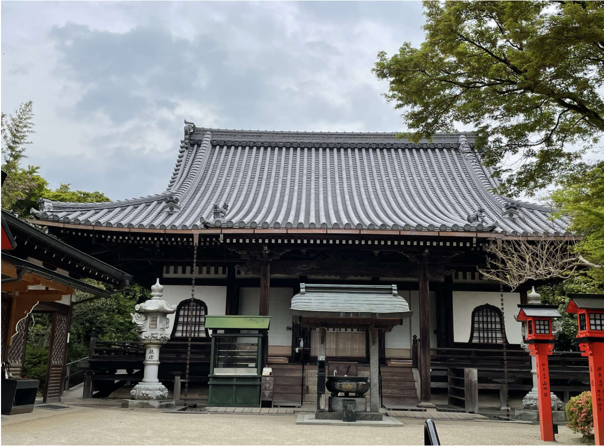
修理後の律院本堂
