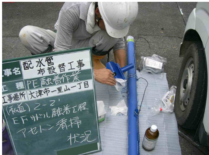
・融着箇所加工状況(アセトン清掃:サドル)
