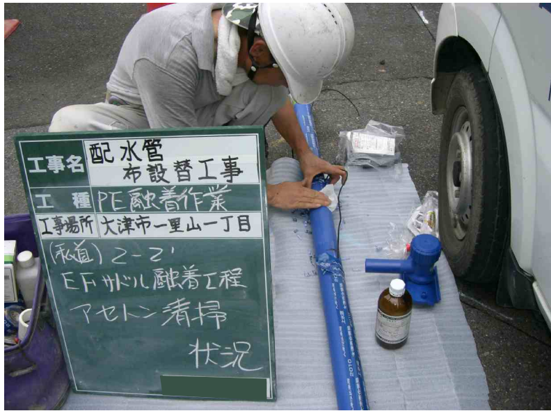
・融着箇所加工状況(アセトン清掃:サドル)
