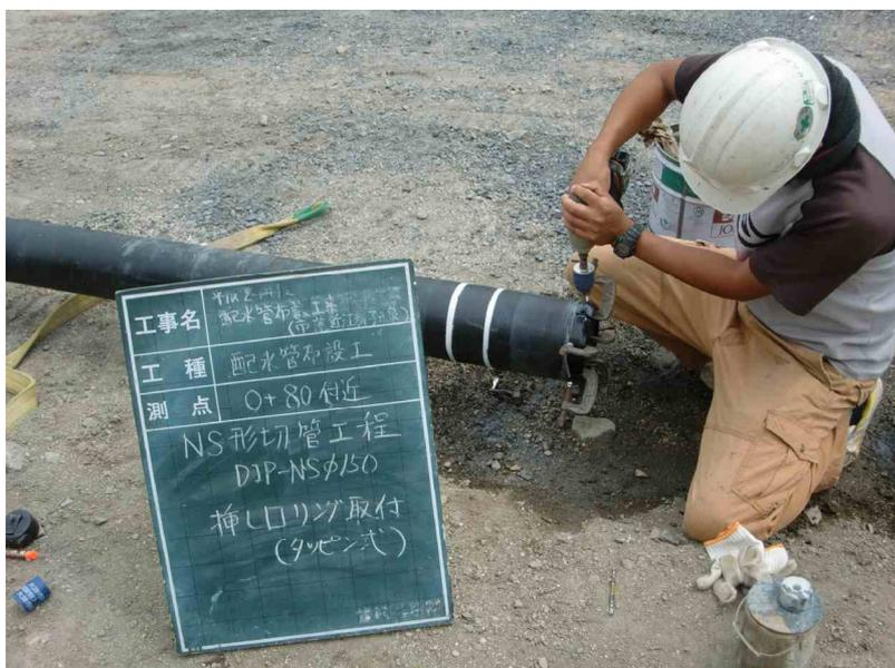
・タッピンネジ締め付け
