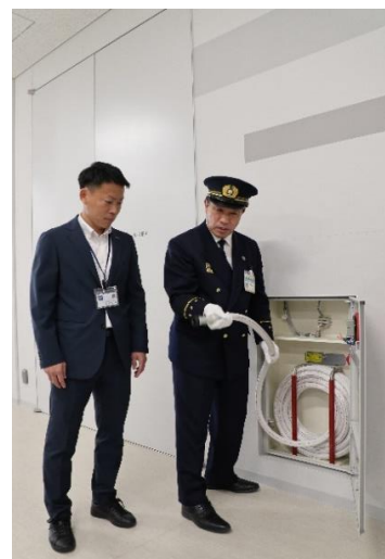
【消防用設備を確認する様子】
