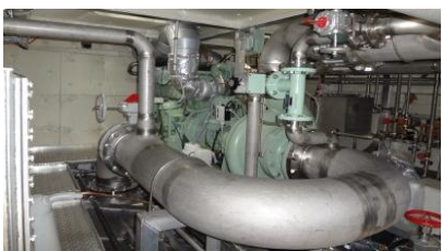
消防ポンプ (8000ℓ/分)
