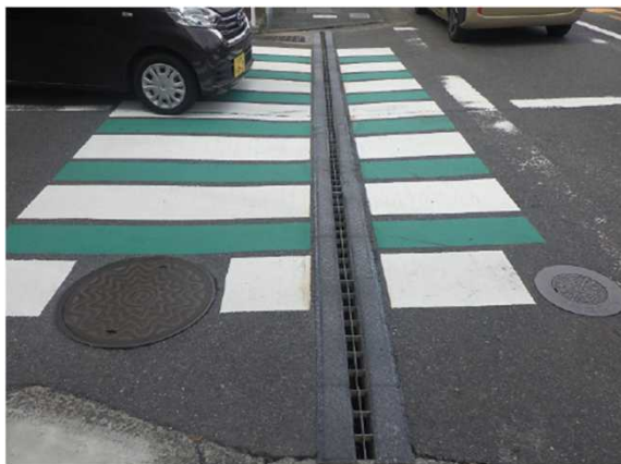
写真1. 鋼製蓋に滑り止め設置 （瀨田小通学路、大津守山近江八幡線）
