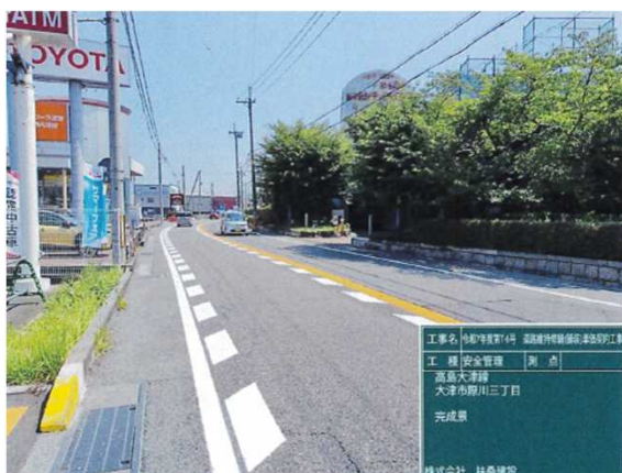
写真3. 減速マークの設置（高島大津線）
