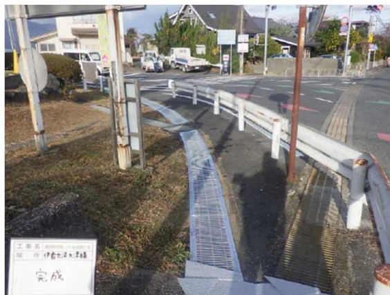
写真2. グレーチングの設置 （仰木小通学路、伊香立浜大津線）
