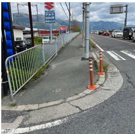
写真 1. ラバーコーンの設置 (和邇小通学路、高島大津線)
