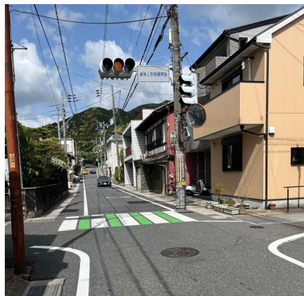
写真 2. 横断歩道のグリーン塗装補修 (長等小通学路、伊香立浜大津線)
