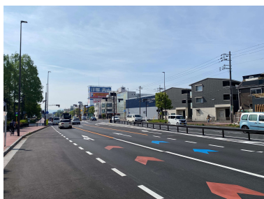
写真 3. 右折レーンの延伸（サンシャインビーチ交差点）
