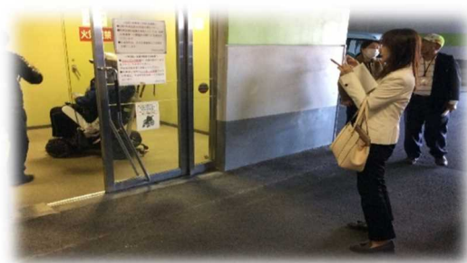
市民文化会館の地下エレベーター前 エレベーターの案内表示がない。
