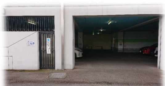
市民文化会館の地下エレベーター前 エレベーターの案内表示の設置。
