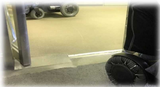
市民文化会館の地下エレベーター前 車椅子でギリギリ通れるぐらいの狭さ。
