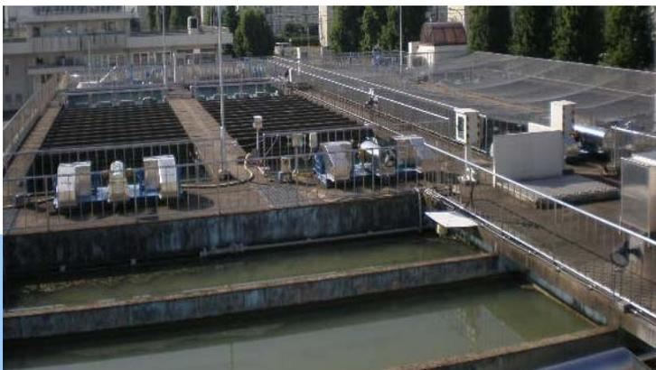
**膳**所浄水場は、膳所・石山地区市街地の給水量増加に対応するため、第3次拡張事業（昭和24年度～32年度）において、旧膳所城二の丸跡に5,000m<sup>3</sup>/日の緩速ろ過池を建設し、第4次拡張事業（昭和35年度～40年度）で、初めて二段ろ過方式を採用して、15,000m<sup>3</sup>/日に拡張し、さらに、水需要の増大に対応するため、第5次拡張事業（昭和42年度～51年度）で急速ろ過池を建設しました。第7次拡張事業（昭和57年度～平成5年度）で、緩速ろ過池を撤去、急速ろ過池を建設し、浄水能力48,800m<sup>3</sup>/日となりました。
