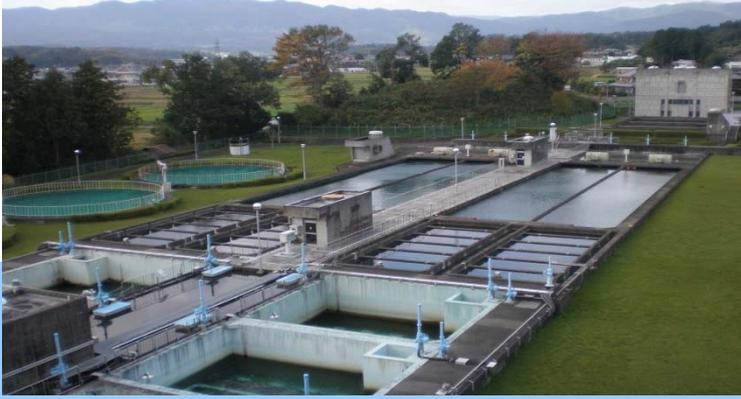
**真**野浄水場は、本市北部地域から中部地域の急速な発展に伴う水需要に対応するために、第6次拡張事業の一環として建設、昭和55年7月より通水を開始しています。第8次拡張変更事業（平成20年度～27年度）に伴い、平成22年に45,000m<sup>3</sup>/日に能力を拡張しました。本市では、初めて北湖の表流水を原水とし、処理した水は北部低区地域に自然流下方式で給水し、山間に伸びる住宅地へは、高区配水池を経由して給水しています。また、異臭味対策として、粉末活性炭接触池を設けています。
