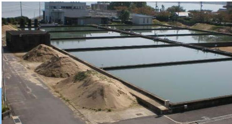
**柳**が崎浄水場は、本市における上水道の発祥の地で、昭和3年に山上浄水場（昭和44年に廃止）の源地として設置されました。昭和23年に15,000m<sup>3</sup>/日の緩速ろ過池が建設され、山上浄水場にかわり本市の中心的な浄水場となりました。
