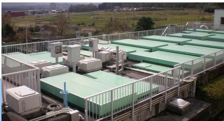
**比**良浄水場は、広域的に融通可能な給水を実現するために、南北に細長い志賀地域を適正な配水区域に分け、志賀町上水道第1次拡張事業（昭和60年度～平成元年度）において志賀第2浄水場として建設されました。平成元年4月に通水を開始し、大津市との合併（平成18年）に伴い比良浄水場と名称を変更しました。北湖の表流水を原水とし、処理した水は低区地域に自然流下方式で給水し、山間住宅地域へは高区配水池を経由し給水しています。
