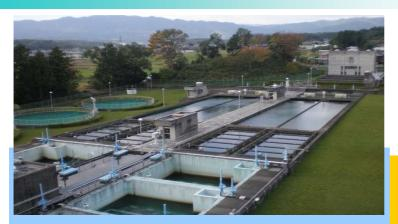
野浄水場は、本市北部地域から中部地域の急速な発展に伴う水需要に対応するために、第6次拡張事業の一環として建設、昭和55年7月より通水を開始しています。第8次拡張変更事業(平成20年度~27年度)に伴い、平成22年に45,000m³/日に能力を拡張しました。本市では、初めて北湖の表流水を原水とし、処理した水は北部低区地域に自然流下方式で給水し、山間部に伸びる住宅地へは、高区配水池を経由して給水しています。また、異臭味対策として、粉末活性炭接触池を設けています。。
