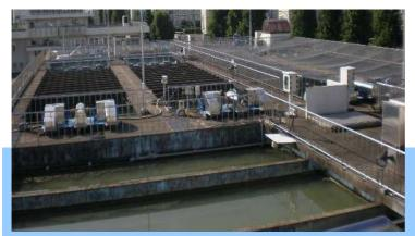
計画 所浄水場は、膳所・石山地区市街地の給水量増加 に対応するため、第3次拡張事業(昭和24年度~32年度)において、旧膳所城二の丸跡に5,000m³/日の緩速ろ過池を建設し、第4次拡張事業(昭和35年度~40年度)で、初めて二段ろ過方式を採用して、15,000m³/日に拡張し、さらに、水需要の増大に対応するため、第5次拡張事業(昭和42年度~51年度)で急速ろ過池を建設しました。第7次拡張事業(昭和57年度~平成5年度)で、緩速ろ過池を撤去、急速ろ過池を建設し、浄水能力48,800m³/日となりました。
