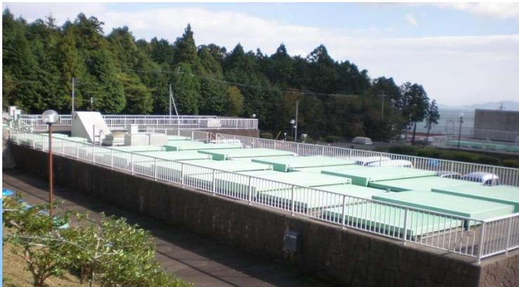
**八**屋戸浄水場は、志賀地域の発展に伴う水需要に対応するために志賀町上水道第2次拡張事業（平成8年度～平成12年度）の一環として志賀第1浄水場として建設され、平成12年4月に通水を開始しました。その後、大津市との合併（平成18年）により八屋戸浄水場と名称を変更しました。北湖の表流水を原水とし、処理した水は低区地域に自然流下方式で給水しています。
