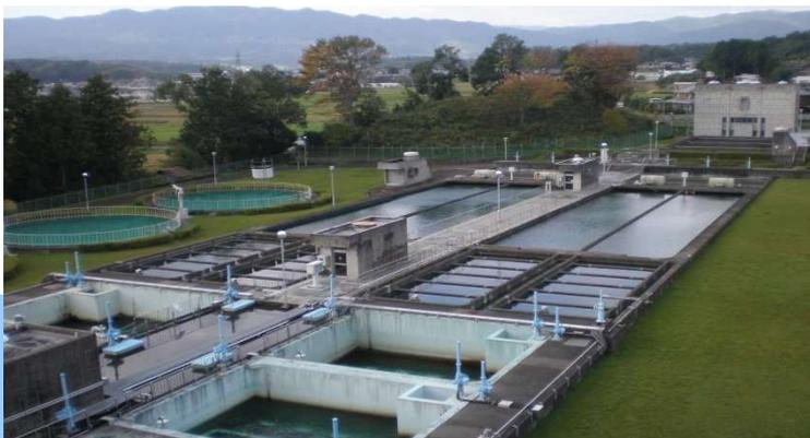
**真**野浄水場は、本市北部地域から中部地域の急速な発展に伴う水需要に対応するために、第6次拡張事業の一環として建設、昭和55年7月より通水を開始しています。第8次拡張変更事業（平成20年度～27年度）に伴い、平成22年に45,000m<sup>3</sup>/日に能力を拡張しました。本市では、初めて北湖の表流水を原水とし、処理した水は北部低区地域に自然流下方式で給水し、山間部に伸びる住宅地へは、高区配水池を経由して給水しています。また、異臭味対策として、粉末活性炭接触池を設けています。
