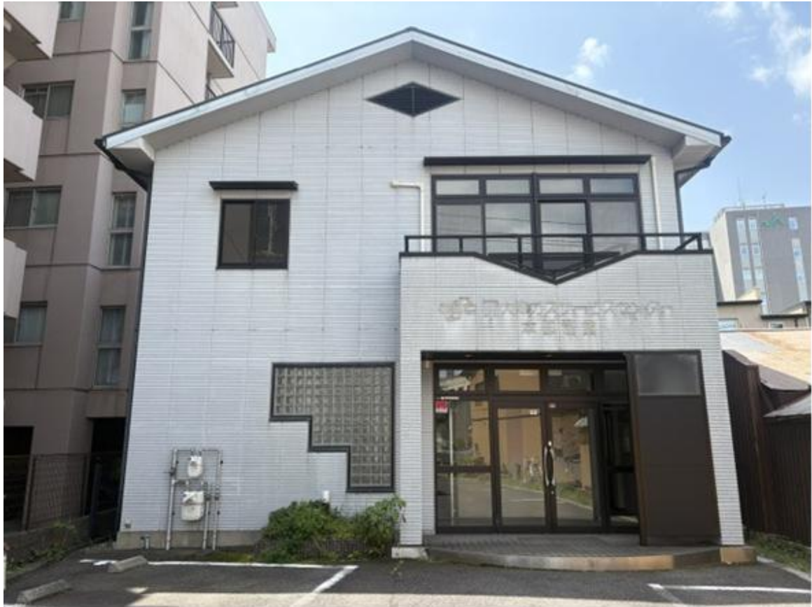
現況写真（建物・全体）
