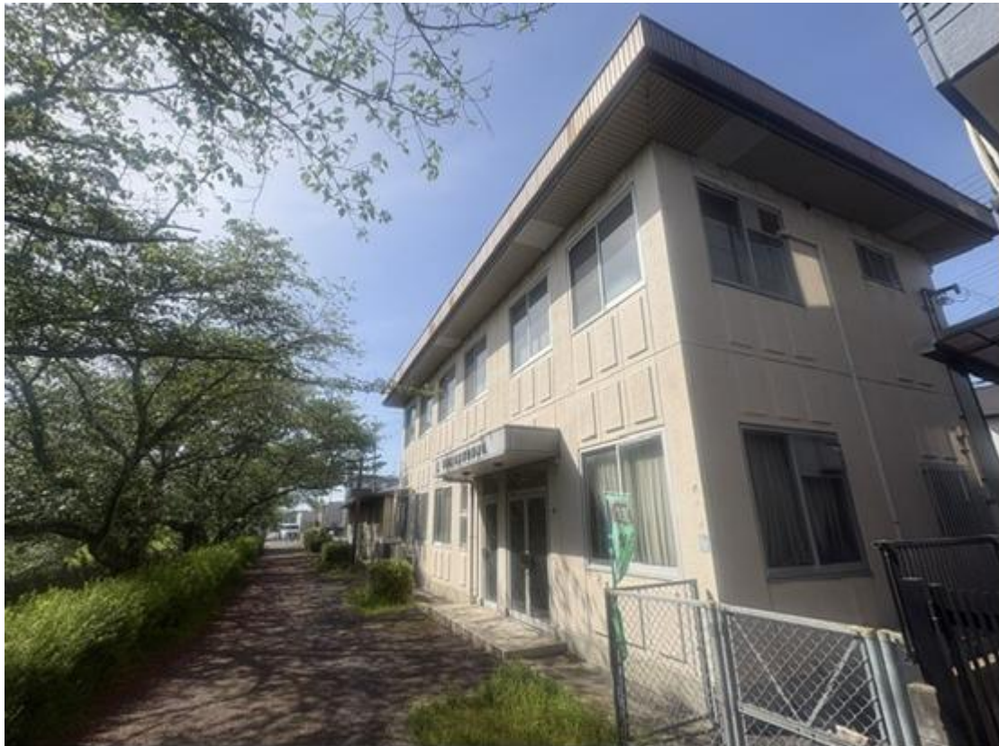
現況写真（建物南側・北側）
