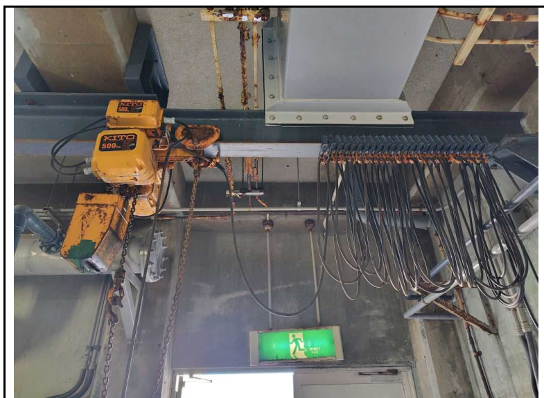
大津終末処理場 II系最終沈殿池
