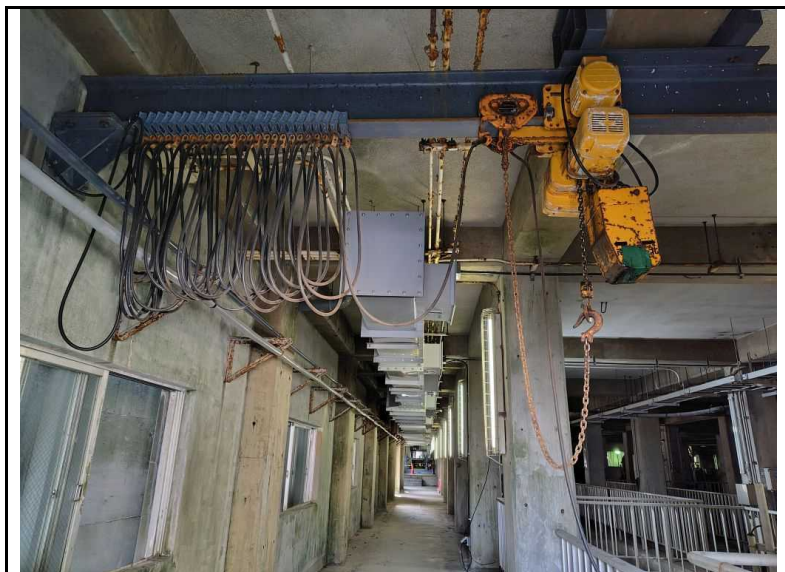
大津終末処理場 II系最終沈殿池
