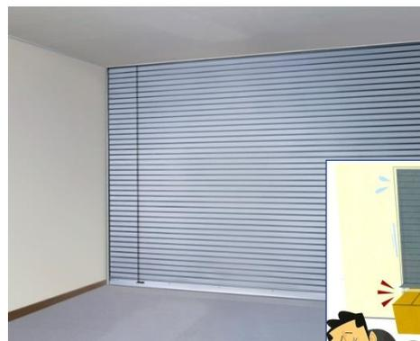
防火扉や防火シャッターの作動不良、及びその周辺部に放置された物品等により適切に作動しない場合、火災による被害を大きくする原因となります。
