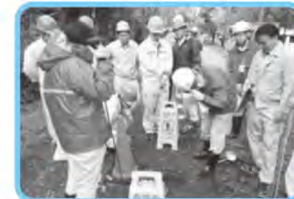
漏水調査訓練 地中の水道管から水が漏れていないか確認する訓練です。
