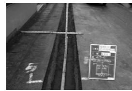
ガス管を入れる工事の様子
