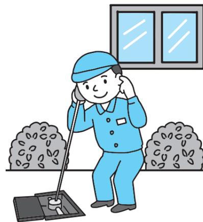
敷地内の水道メーターなどに音聴棒(※)をあて漏水音の有無を調査します。
