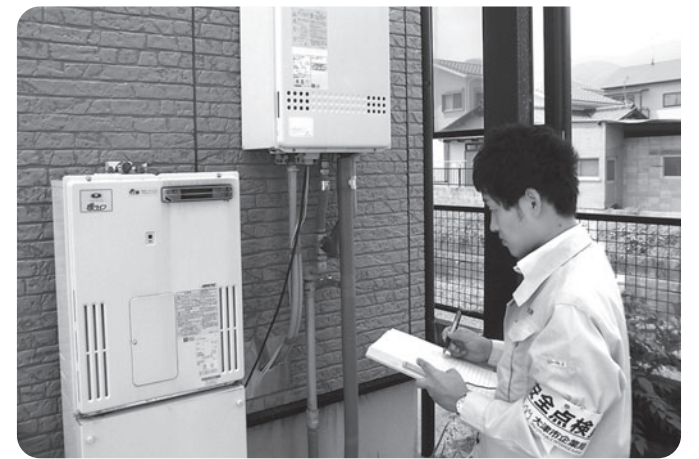
給湯器の点検
