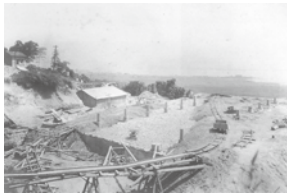
山上高区配水池築造工事
